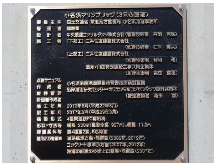
橋台部に取り付けられた橋歴板
