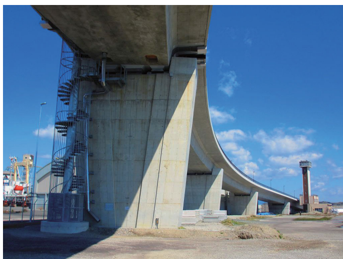
3号ふ頭部橋梁 : PC 4径間連続箱桁橋 L=220m
