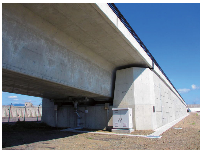
橋梁から擁壁区間に続く省隠しとフェイスライン
