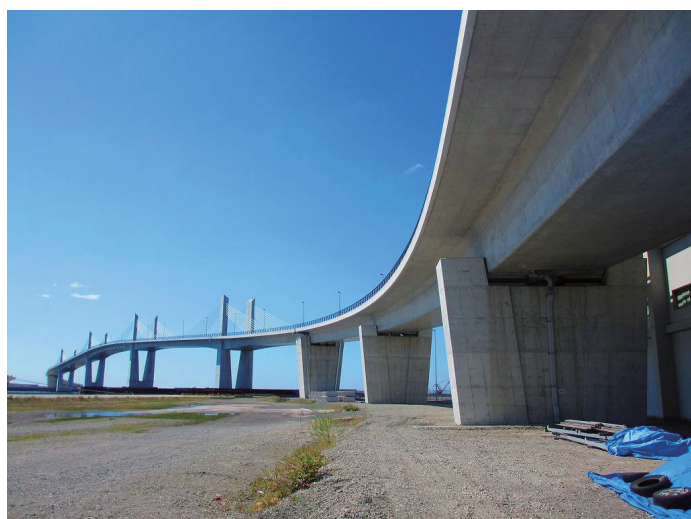
3号ふ頭部橋梁 (CFK 設計) から海上部橋梁に続く眺め
