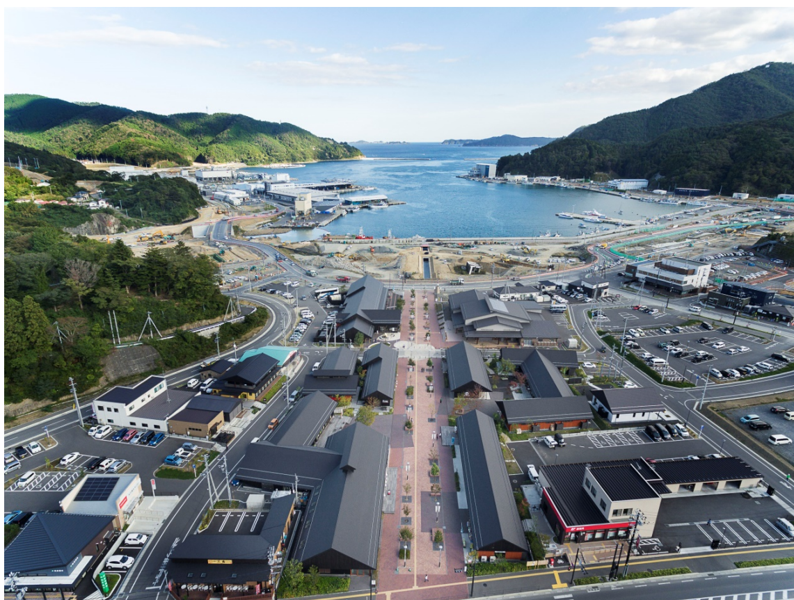
「レンガみち」は、駅前広場から女川湾を一直線につなぎ、海を眺めて暮らすまちの骨格を形成している
