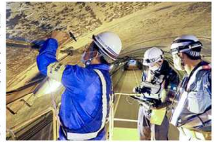
中央復建コンサルVが実施したデジタル打音検査
