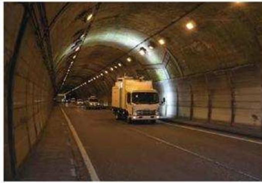
レーザーキャナ計測状況
