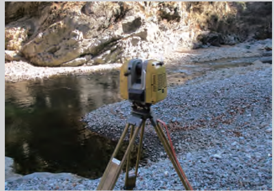
地上型レーザー計測機による三次元測量 3D survey using laser measurement
