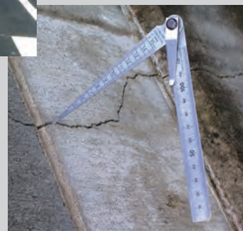
損傷調査 A damage survey
