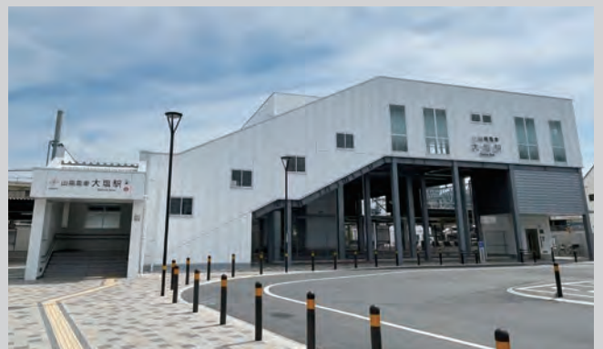
山陽電車 大塩駅の設計 Oshio Station, Sanyo Electric Railway
