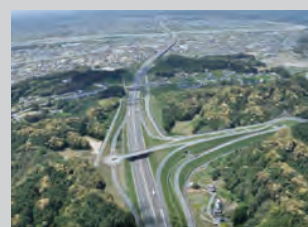
ラウンドアバウトを利用したスマートIC A smart interchange using roundabout
