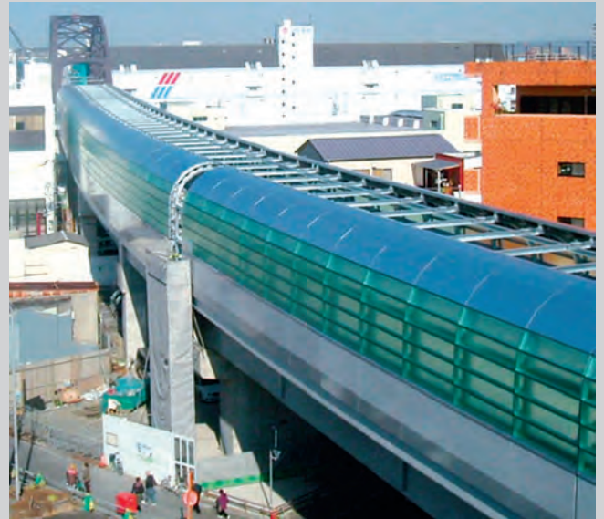
生活環境との調和を考えたセミシェルター型防音壁の設計 (阪神なんば線 写真提供西大阪高速鉄道株式会社)
