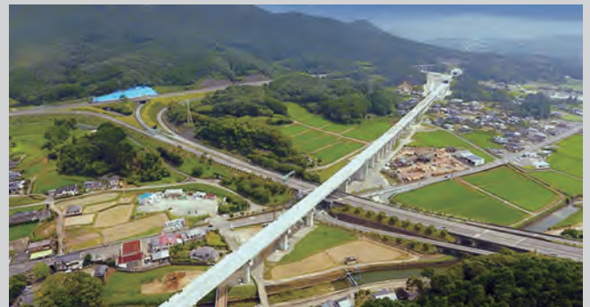
九州新幹線 袴野架道橋の設計 Hakamano Overpass, Kyusyu Shinkansen
