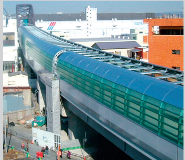
生活環境との調和を考えたセミシェルター型防音壁の設計 The design of semi-shelter type noise barriers to preserve a peaceful living environment
