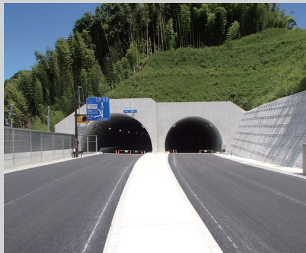
超近接無導坑めがねトンネル Ultra-close non-pilot glasses tunnel
