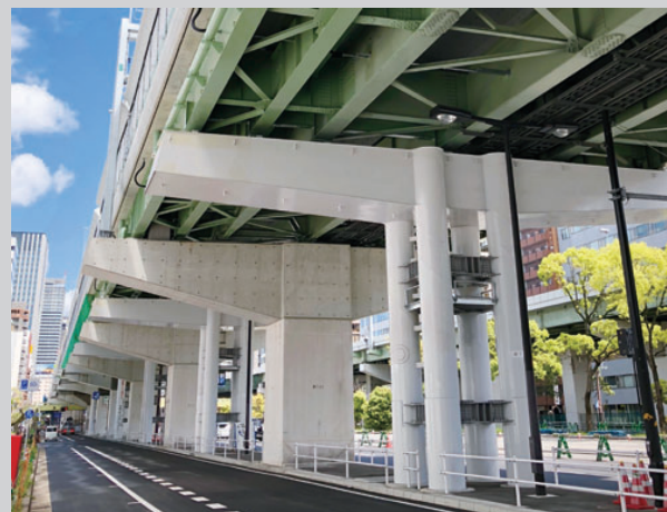
「西船場ジャンクション(大阪港線拡幅部、渡り線)」 鋼床版箱桁橋、鋼連続鉄桁橋の改築設計(土木学会田中賞2019) Nishisenba JCT (Osaka Port Line Widening Department, Crossover Line), a steel slab box girder bridge, a successive steel girder bridge
